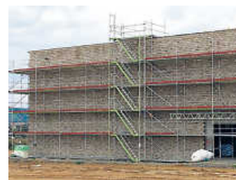
Setzen der Klinkerfassade an der Doppel-Sporthalle
