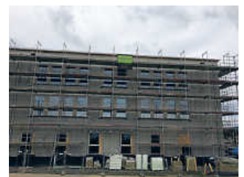
Neue Fenster in der Grundschule Limespark Fotos: Stadt Öhringen
